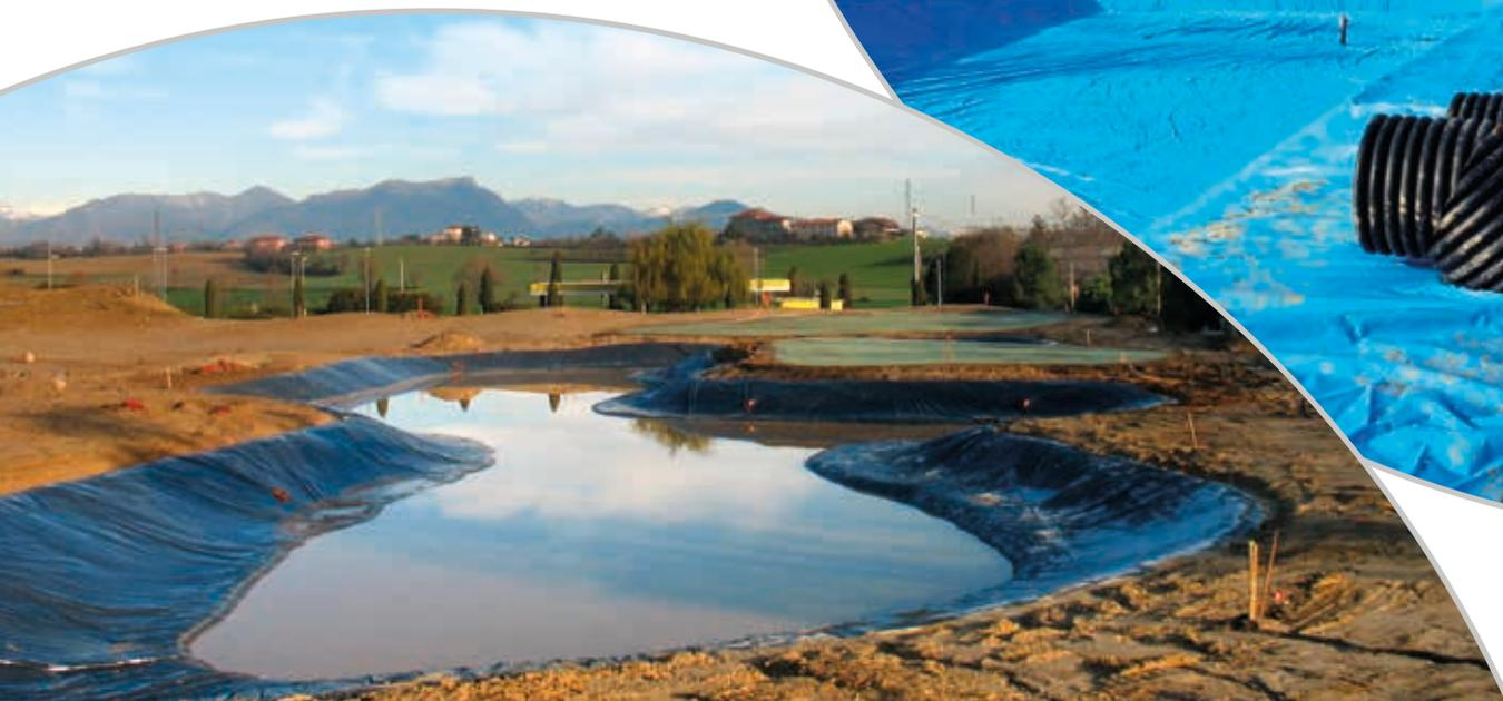
IDROEVA SONO TELI IN EVA/C, COPOLIMERO DI ETILENE ED ACETATO DI VINILE, AD ALTO TENORE DI VA, CON OTTIME CARATTERISTICHE DI ELASTICITÀ, E PERCIÒ DI ADATTAMENTO A PICCOLE ASPERITÀ DEL TERRENO, DI RESISTENZA ALLA PERFORAZIONE E DI RESA SUPERFICIALE, GRAZIE AL PESO SPECIFICO DI SOLO 520 G/M<sup>2</sup>. SONO DISPONIBILI ANCHE FORMULAZIONI ADATTE PER IMPIEGO ALIMENTARE, UTILIZZABILI PER BACINI DI ACQUA POTABILE ED ALLEVAMENTI DI PESCE.
